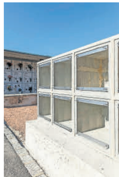
AMPLIAMENTO Sono stati realizzati nuovi loculi. (Foto Reguzzi)
