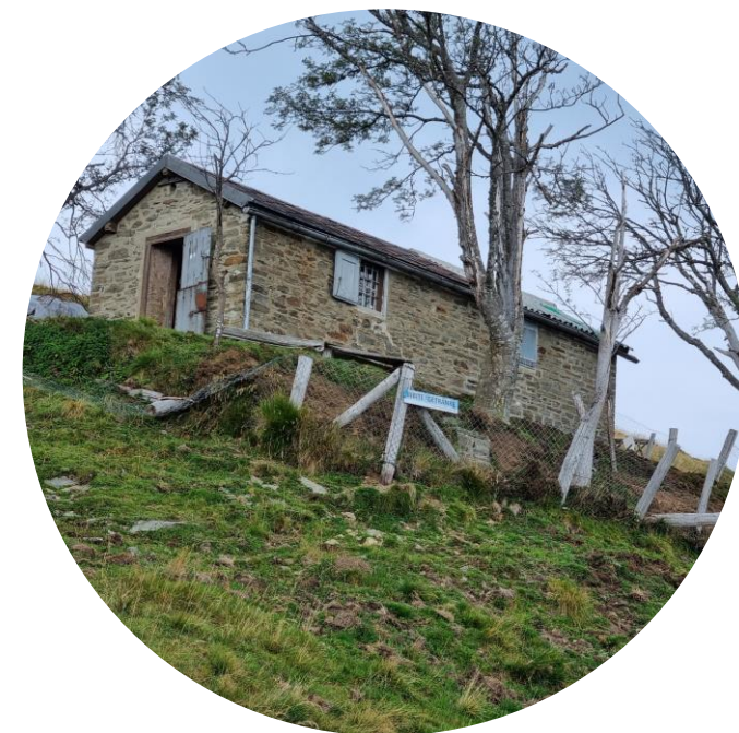
Fondazione Malcantone Ristrutturazione Casermetta Agario
